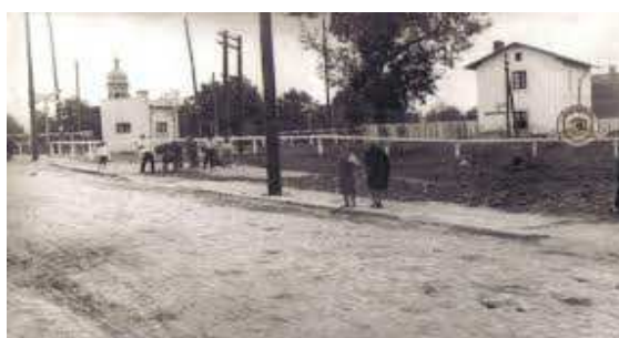
Vechea bariera de la Cimitirul Sudic
