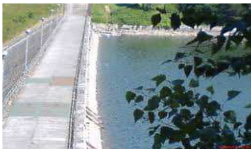
dig baraj gozna
