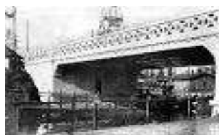
Pod din beton armat proiectat si executat in anul 1906 de inginerul Gogu Constantinescu
